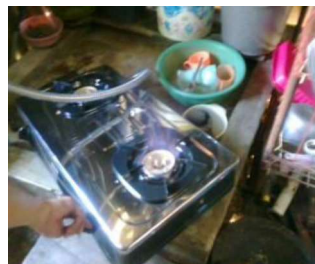
Gambar 5. Instalasi Pipa Gas ke rumah
