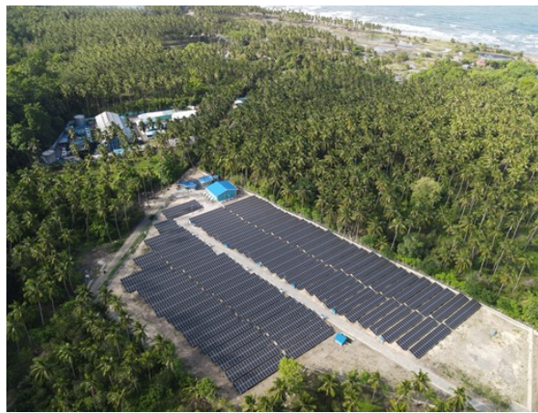
Gambar 1. Tampak atas PLTS Selayar
