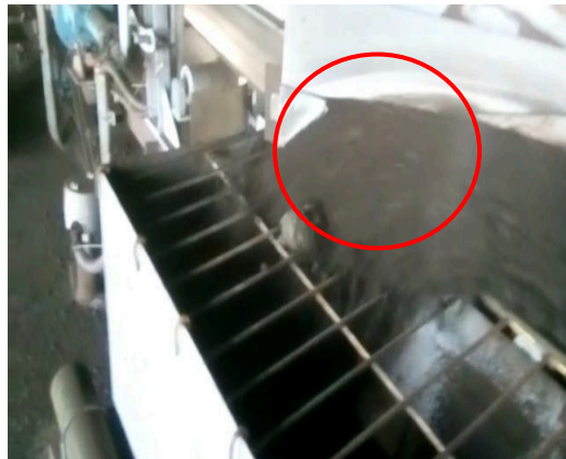
Gambar 5. Hasil pengujian screen hopper coal bunker dengan flow batubara 125 t/h.
