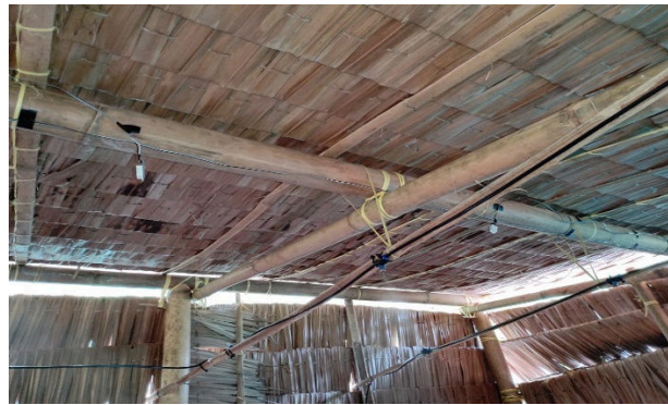
Gambar 3. Nozzle-nozzle yang terpasang pada langit-langit dalam kumbung jamur.
