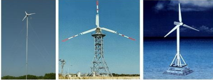
Gambar 2. Tower PLTB (kiri) Guyed (Tengah) Lattice (kanan) Mono-structure
