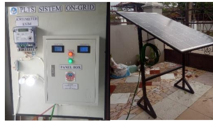
Gambar 7. Hasil Rancangan PLTS On-Grid
