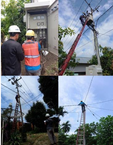
Gambar 4. Pengecekan data trafo, hubungan fasa dan arus beban pada tiang
