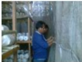
Gambar 4.2 Pemasangan tirai dan instalasi pipa air
