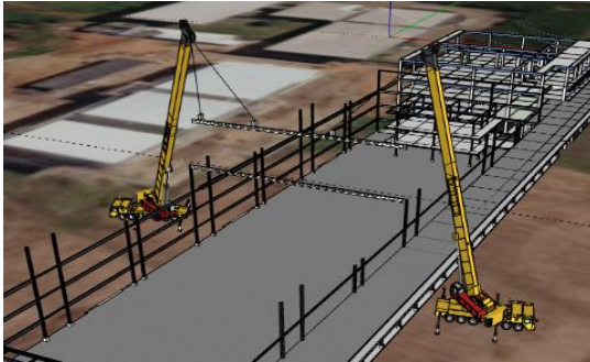
Gambar 6. Pengangkatan Balok Castella Ke Top Kolom
